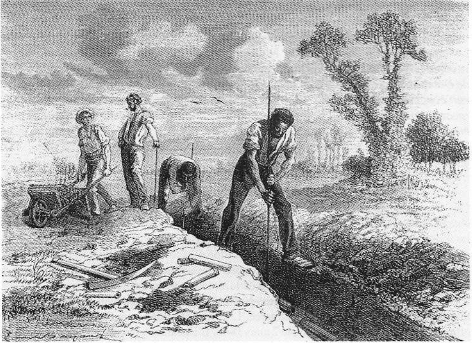
Ouvriers posant des tuyaux de drainage. In : Les Merveilles de la Science , Louis Figuier, 1868. Éditeur Furne, Jouvot et Cie, rue St-André-des-Arts.
