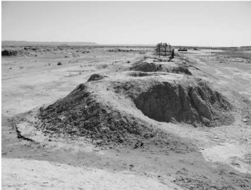
Ligne de foggaras au Maroc, près de Taroudant. Sur la gauche, on devine une seconde ligne, parallèle à la première et même une troisième. La fonction principale du système est d'intercepter les eaux et pas uniquement de les acheminer comme disent les guides ! Photo auteur.
