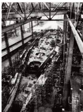
Figure 5 – Construction du Bismarck en cale sèche. Chantiers Blhom & Voss
