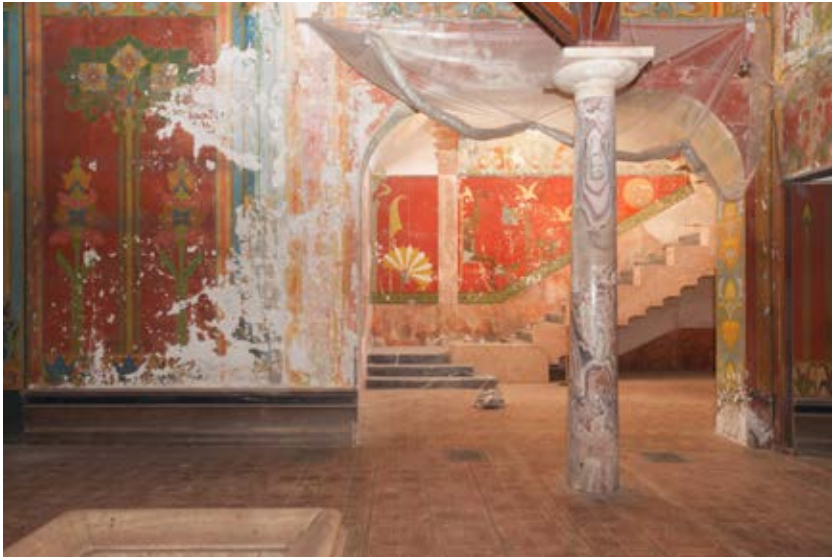
Fig. 2. – Atrium avant restauration (©M. Perraud, 2008).
