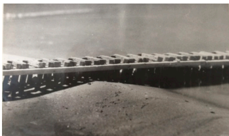
Exemple d'épis perméables réalisés sur les bords du Golfe de Beauduc (bouches du Rhône) dans les années 1950 1960.
