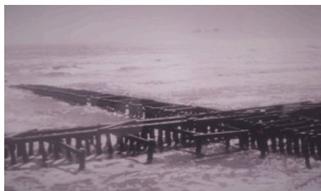
Exemple d'épis perméables réalisés sur les bords du Golfe de Beauduc (bouches du Rhône) dans les années 1950 1960.
