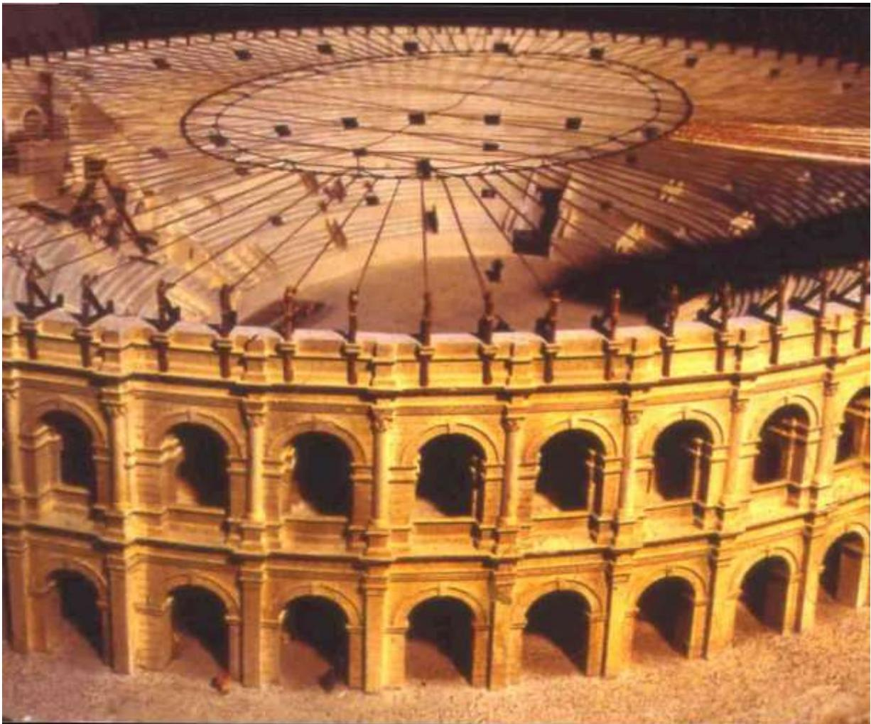
Des marins en déployaient les parties par cordages et poulies suivant l'heure et la saison. Des décors, collines, maisons ou forêts pouvaient surgir du sous-sol grâce à des machines roulantes et au plancher de bois amovible du centre de l'arène. Des souterrains et trente monte-charge amenaient gladiateurs
