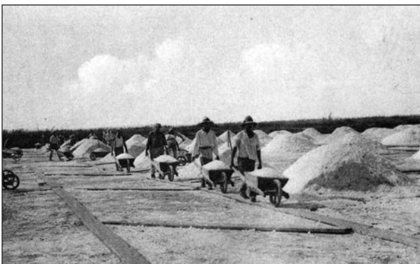
Le roulage du sel : on remarque le chemin de planches disposées sur le sol afin de faciliter le transport du sel avec des brouettes.
