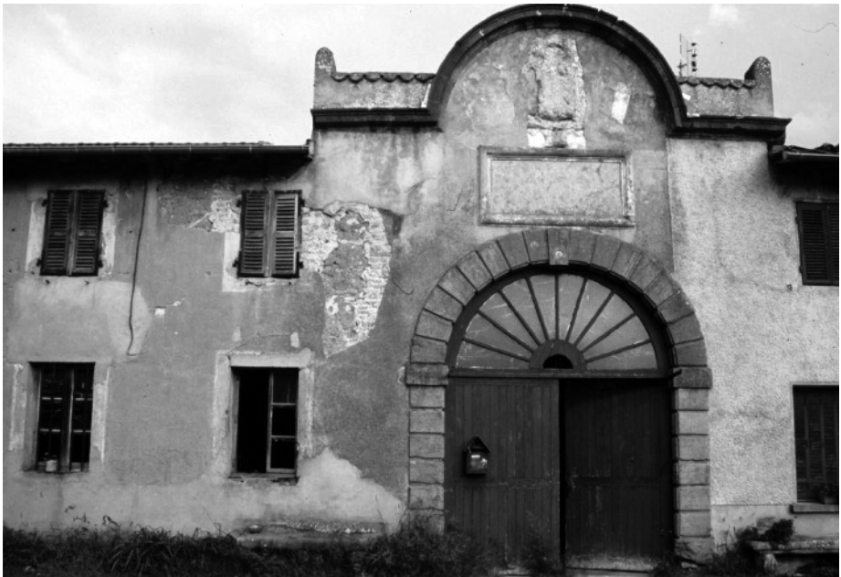
Photo 1 – Le portail de la Saulsaie, avant restauration.
