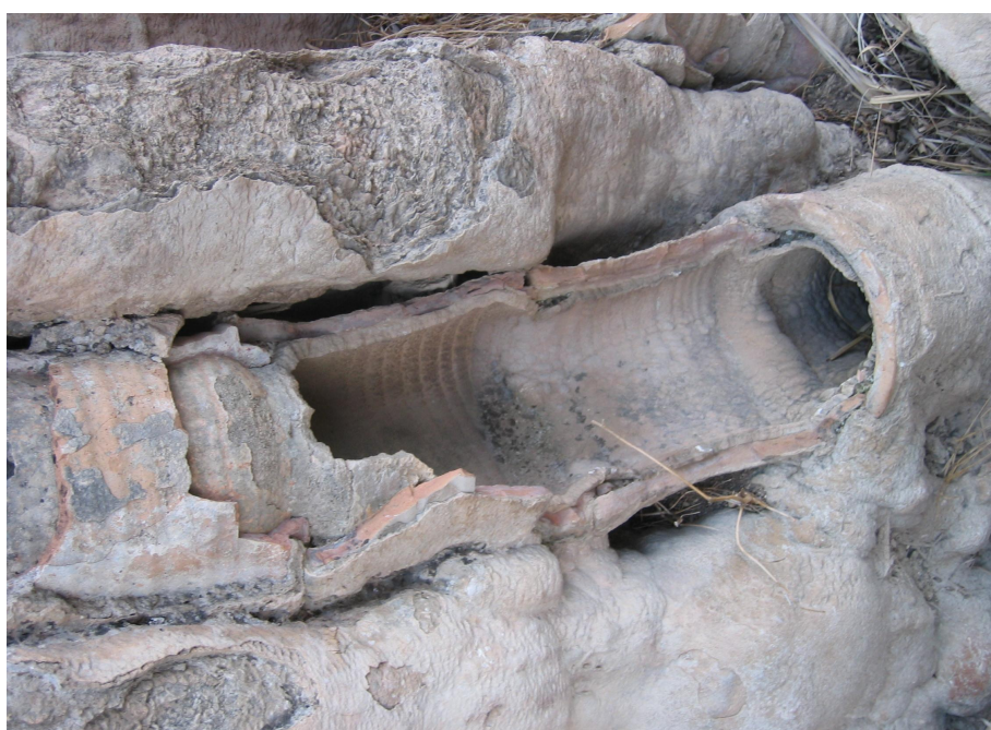
Canalisation romaine. Elle est en poterie mais encroutée par des dépôts de carbonate de calcium. Site de Perge (Turquie)
